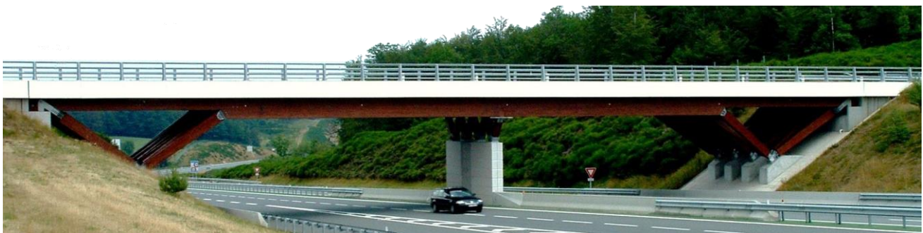
Figure 1 : Pont bois-béton de l'aire de Chavanon (Corrèze)
